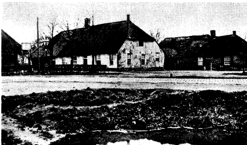
Afb. 1 De oorspronkelijke bebouwing van de westzijde van het Hasseltplein met de boerderij van Fouchier uit 1608 en de wolspuul; 1928.
